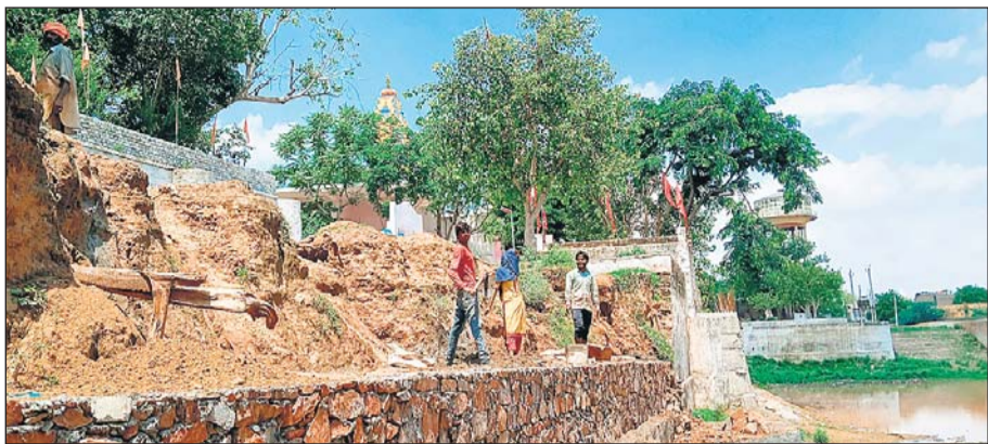
ग्राम पंचायत नीमराना के बैंक खाते से बैंक डेट में राशि निकालकर बाबा शिव स्वरूप मंदिर के सामने तालाब निर्माण कार्य किया जा रहा है।
