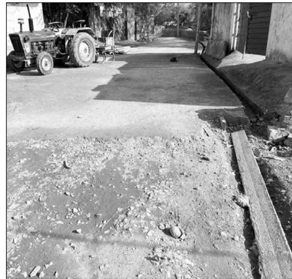
मांडलगढ़ के बिटुलपुरा गांव में घटिया निर्माण सामग्री से सीसी सड़क निर्माण कर बेतरतीब नाली बनाई जा रही है।
