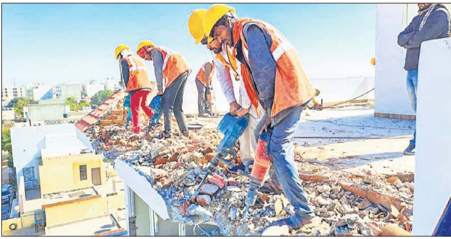
शिक्षक भर्ती परीक्षा पेपर लीक मामले के मास्टर माइंड भूपेंद्र सारण के मकान के अवैध निर्माण को जेडीए ने तीन दिन की कार्रवाई में ध्वस्त कर दिया।
