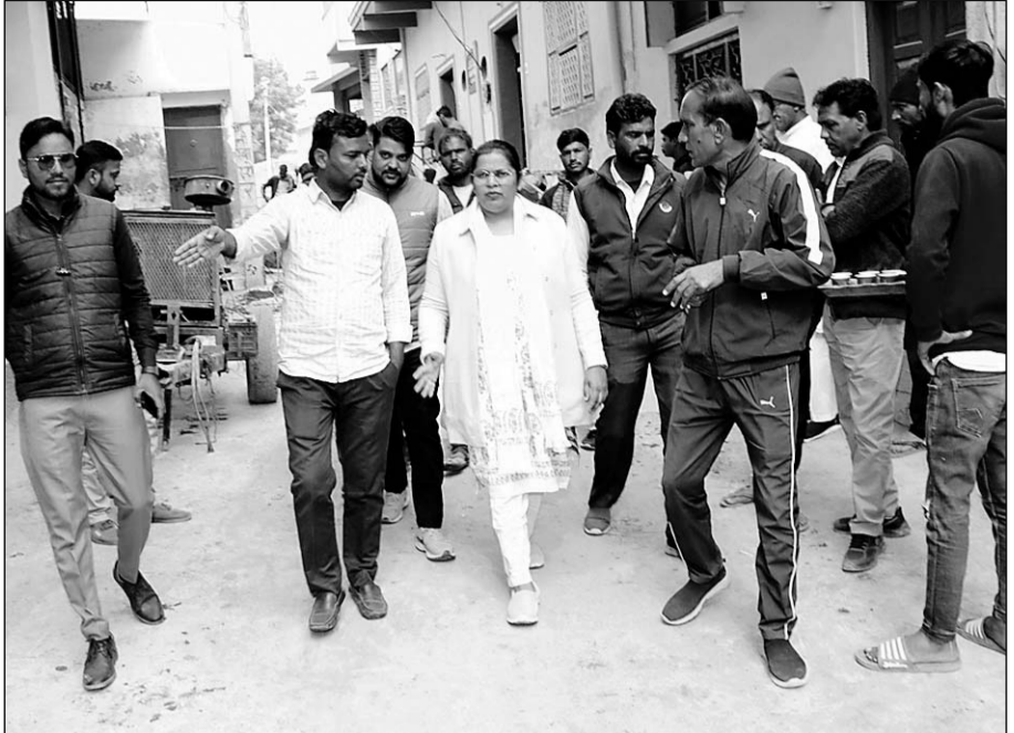
सभापति पायल सैनी ने रविवार को वाई 58 में निर्माणाधीन सीसी सड़क का अवलोकन किया।
