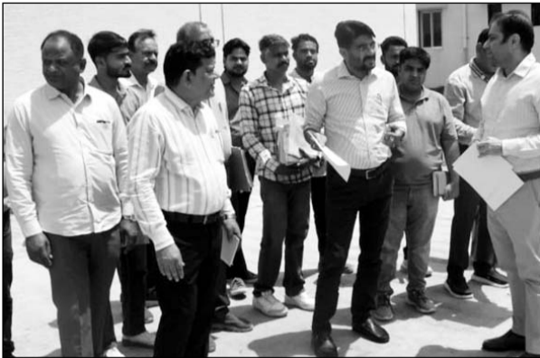
कोटा जिला कलेक्टर पीयूष समारिया ने निर्माणाधीन पीएम ई-बस डिपो एवं चार्जिंग स्टेशन का निरीक्षण किया।
