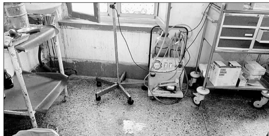
पावटा सीएचसी के इमरजेंसी वार्ड में पानी टपकने से उपकरण खराब हो रहे हैं।
