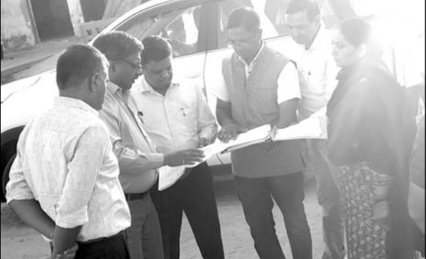
आवासन आयुक्त डॉ. रश्मि शर्मा ने गुरुवार को महला पहुंचकर निर्माणाधीन स्वतंत्र आवासों का निरीक्षण किया।
