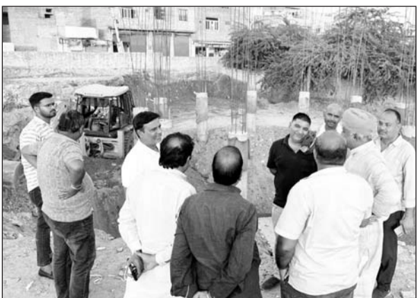
बीकानेर (पश्चिम) विधायक जेटानंद व्यास ने गोपेश्वर मंदिर परिसर में निर्माणाधीन टंकी का निरीक्षण किया।
