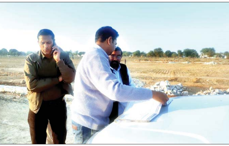
मुहाना गृह निर्माण सहकारी समिति के समापक और जयपुर विकास प्राधिकरण की प्रवर्तन शाखा ने गुरुवार को मुहाना स्थित सचिवालय नगर योजना में अवैध निर्माण व अतिक्रमण को रुकवाया।
