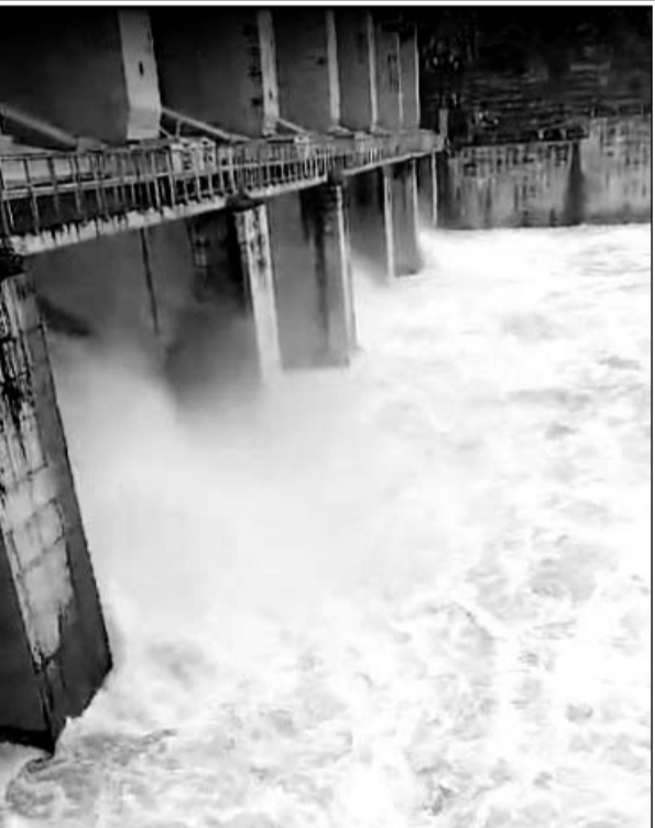
पांचना बांध के तीन गेट खोलकर पानी की निकासी की गई।
