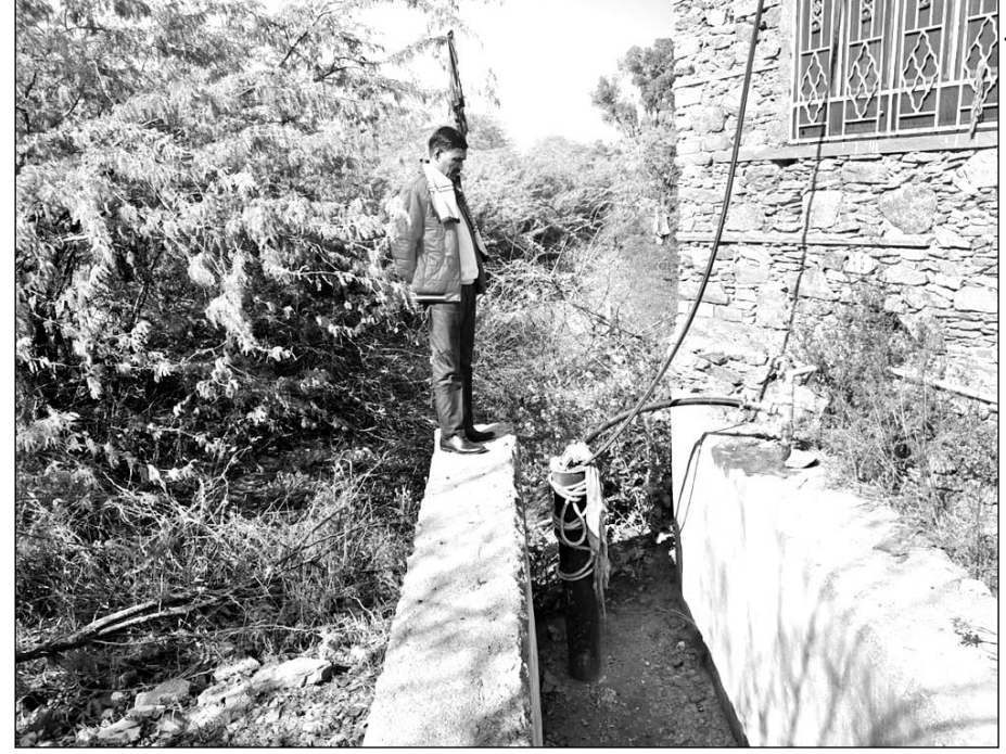
अराई तहसीलदार हरिराम ने बोरवेल का निरीक्षण किया।
