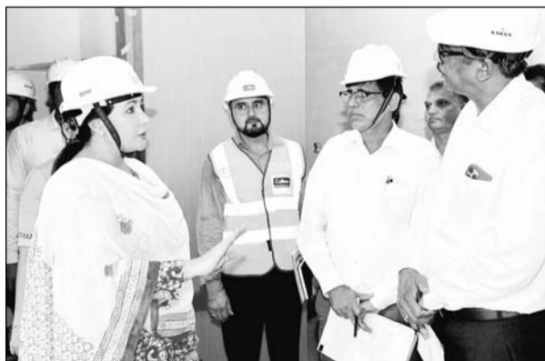
दिया कुमारी ने सोमवार को दिल्ली में निर्माणाधीन राजस्थान हाउस का निरीक्षण किया।
