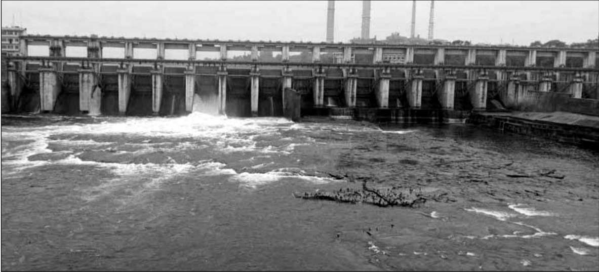
कोटा बैराज से दो गेट खोलकर पानी की निकासी की जा रही है।
