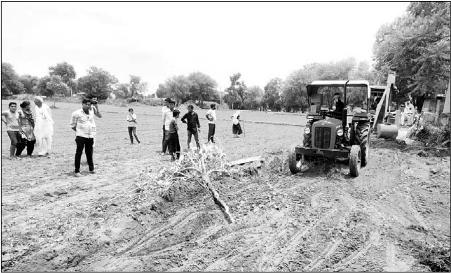
“रास्ता खोलो” अभियान के अंतर्गत खोले गए रास्तों पर ग्रेवल रोड का निर्माण करवाया जा रहा है।
