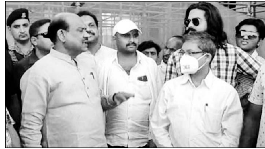
लोकसभा अध्यक्ष ओम बिरला ने रामपुर में बन रहे ट्रिपल आईटी भवन का जायजा लिया।
