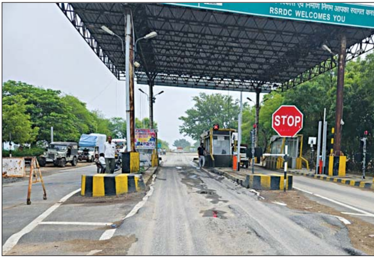
माण्डलगढ़ के त्रिवेणी-जहाजपुर सड़क पर गोपालपुरा टोल प्लाजा पर फर्जीवाड़े से टोल वसूली का मामला सामने आया।
