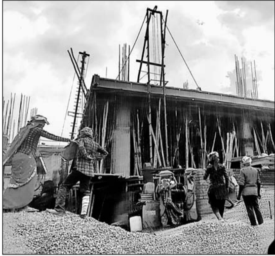
अवैध निर्माण की 20 सितंबर 2021 की निर्माणाधीन तस्वीर।
