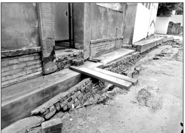
प्रगति नगर में बना रहे नाले की दीवार बारिश में टूटकर बिखर गई।
