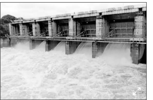
पांचना बांध के पांच गेट खोलकर पानी की निकासी की जा रही है।
