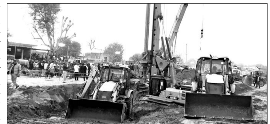
बोरवेल में फंसी बालिका को निकालने के लिए एनडीआरएफ व एसडीआरएफ की टीमें लगी हुई हैं।
