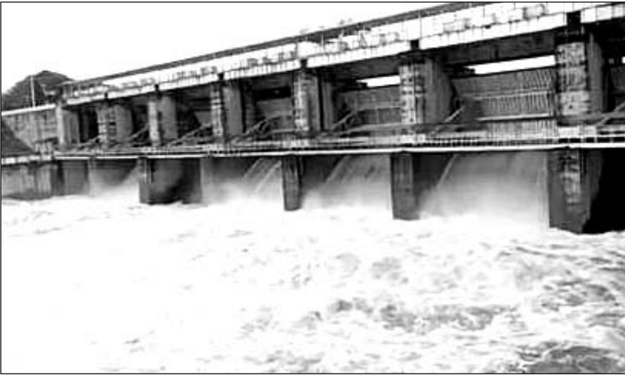
करौली जिले के सबसे बड़े पांचना बांध के चार गेट खोलकर 17496 क्यूसेक पानी निकाला गया।
