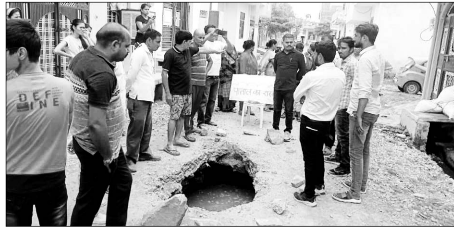
सीवरेज लाइन डालने के बाद बनाई गई सड़क अचानक धंसने से लोगों में आक्रोश उत्पन्न हो गया।
