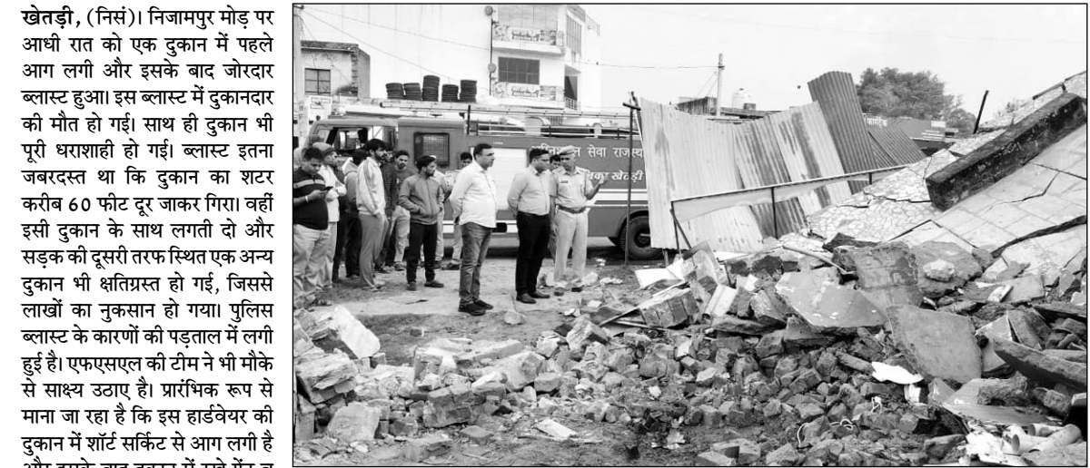
खेतड़ी के निजामपुर मोड़ पर दुकान में आग लगने के ब्लास्ट हो गया। हादसे के बाद पुलिस ब्लास्ट के कारणों की पड़ताल के लिये पहुंची। वहीं एफएसएल की टीम ने भी मौके से साक्ष्य उठाए।
