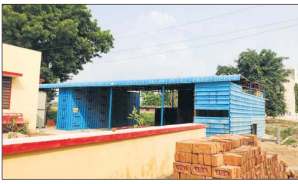
नगर पालिका के वार्ड नंबर 2 में निर्माणाधीन रसोई।
