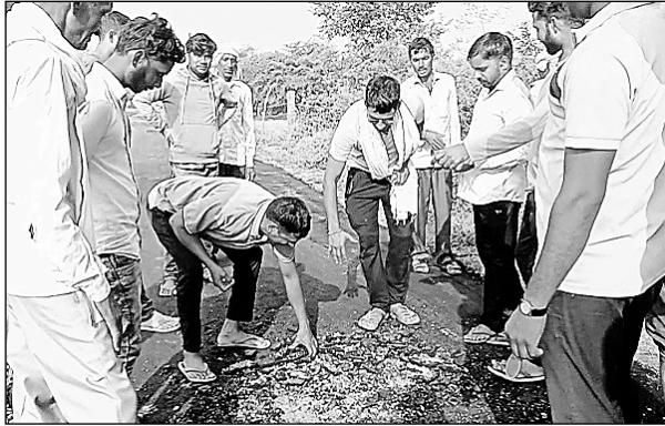
घटिया सड़क निर्माण को दिखाते स्थानीय ग्रामीण।
