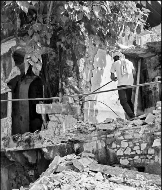
हैरिटेज नगर निगम के किशनपोल जोन की टीम ने इलाके में जर्जर इमारतों को शुक्रवार को ध्वस्त किया।
