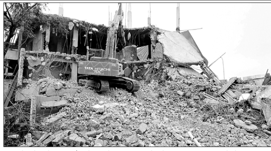
पुष्कर में सरोवर के पास अवैध होटल को पालिका की पोकलेन मशीन की सहायता से तोड़ा गया।
