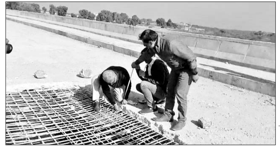
एमएनआईटी के अधिकारियों ने पुलिस के निर्माण कार्य की जांच की।
