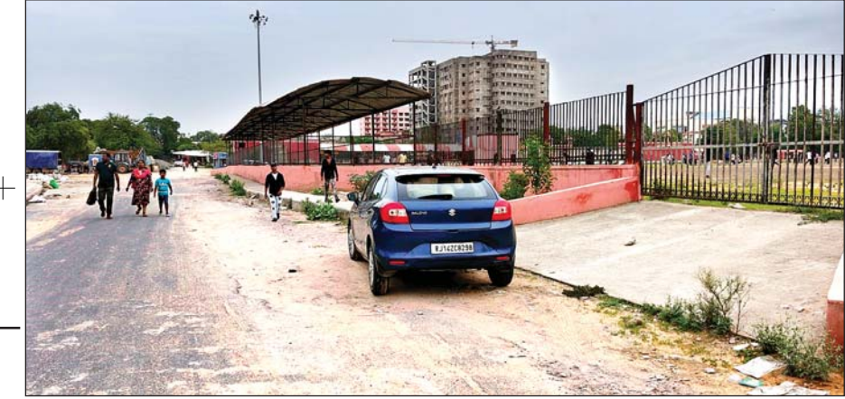
यूनियन क्लब ग्राउंड का पूर्वी गेट इस तस्वीर में देखा जा सकता है। गेट के सामने बनी सड़क यूनियन ग्राउंड को आवॉर्गटिड भूमि पर बनी है। प्रशासन व राज्य सरकार ने यूनियन क्लब से तब तक के लिए उक्त भूमि पर अस्थाई सड़क के निर्माण के लिए अनुमति ली थी जब तक रविन्द्र मंच के सामने बन रही सड़क का कार्य पूरा नहीं हो जाता। परन्तु जिस भूमि पर अस्थाई सड़क बनी है उसे यूनियन क्लब को नहीं लौटाया गया। इसी सड़क से जुड़ी सी-सी रोड, जो सवाई मानसिंह जी की मूर्ति तक जाती है, वह भी यूनियन क्लब की जमीन पर बनी हुई है, जिसे भी यूनियन क्लब को नहीं लौटाया गया।
