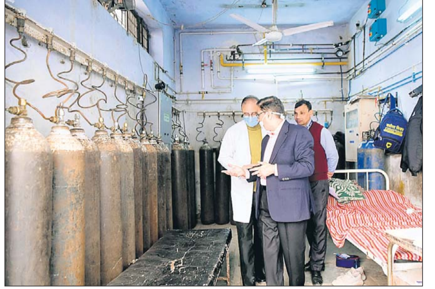
सवाई मानसिंह अस्पताल में माँकड्रिल को लेकर पहले से तैयारियां दिखीं। अधीक्षक डॉ. अचल शर्मा ( सफेद कोट ) ने मंगलवार को ऑक्सीजन प्लांट का निरीक्षण किया।
