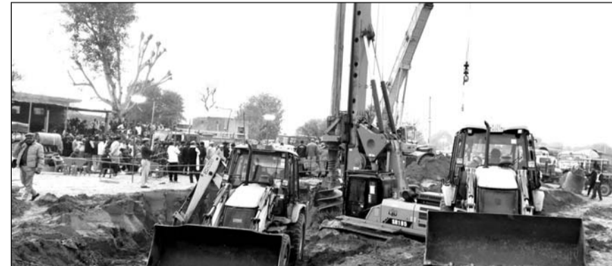
बोरवेल में फंसी बालिका को निकालने के लिए एनडीआरएफ व एसडीआरएफ की टीमें लगी हुई है।
