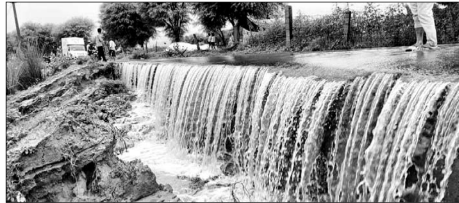
कालाडेरा-विमलपुरा सड़क के ऊपर से पानी गुजरने के कारण सड़क पर कटाव लग गया।
