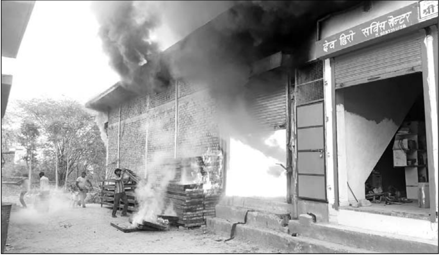
टेंट गोदाम में अचानक भीषण आग लगने से सामान जल गया।
