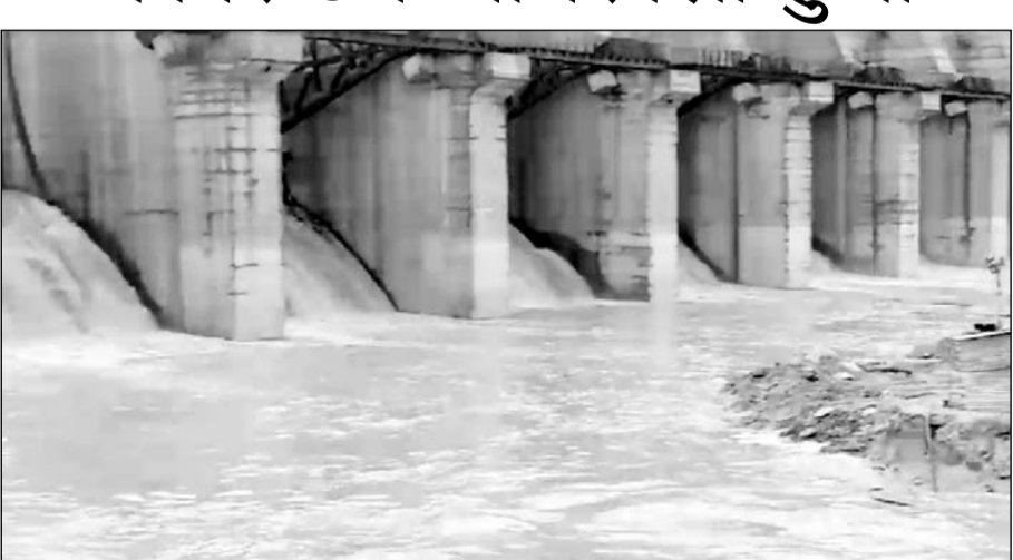
शनिवार सुबह बनास नदी में पानी की आवक बढ़ने से लबालब भरकर कॉपर डेम ओवरफ्लो हो गया।
