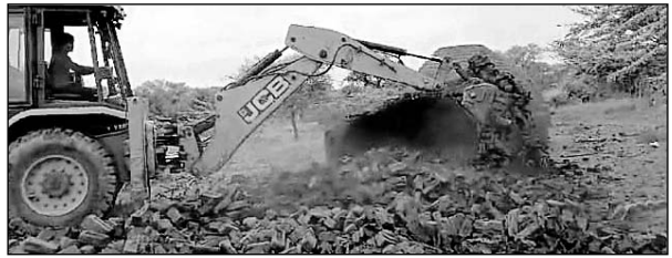
करेड़ा के ग्राम रामपुरिया, ग्राम पंचायत नारेली में अवैध कोयला भट्टियों को ध्वस्त किया।
