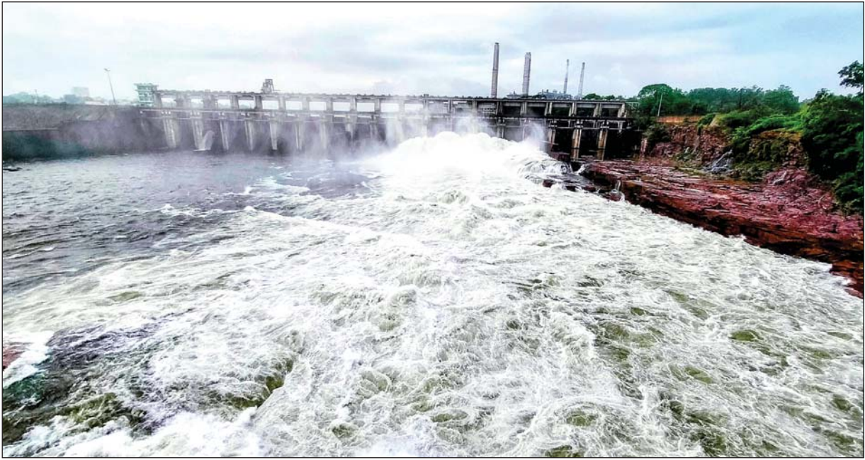
कोटा संभाग में भारी वर्षा के बाद कोटा बैराज के 5 गेट खोल कर पानी की निकासी की गई।
