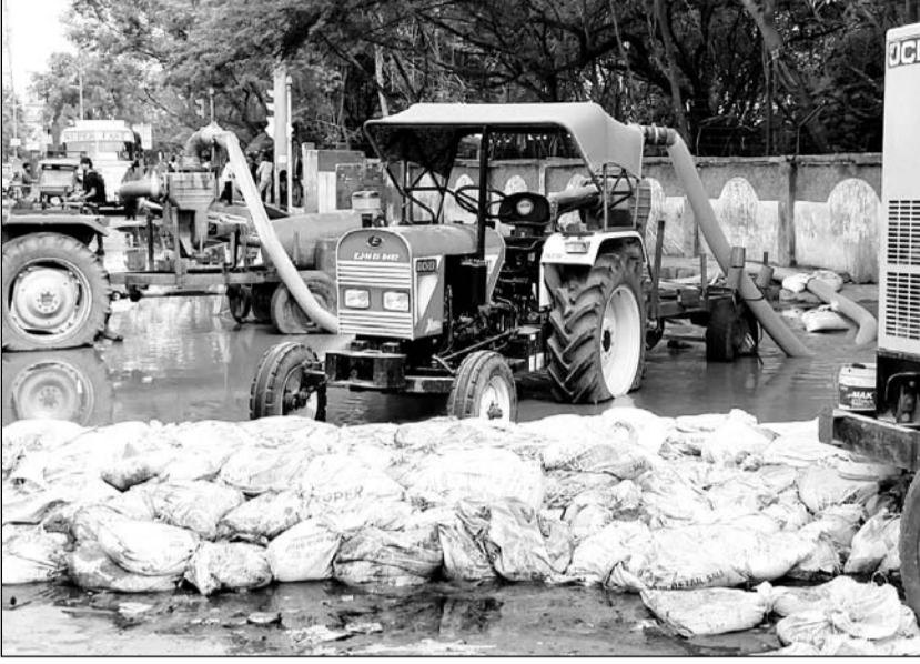
चौमूं पुलिया से झोटवाड़ा की ओर जाने वाले मार्ग पर जे.डी.ए. प्रशासन ने पिछले दिनों जहां सीमेंट सड़क बनाई थी, वहां सीवर लाइन क्षतिग्रस्त हो गई। हालात इतने बिगड़े कि 5 मड पंप लगाकर सड़क से सीवर का पानी हटाना पड़ा, साथ ही आर्मी एरिया की दीवार के पास सड़क की खुदाई भी करनी पड़ी।
