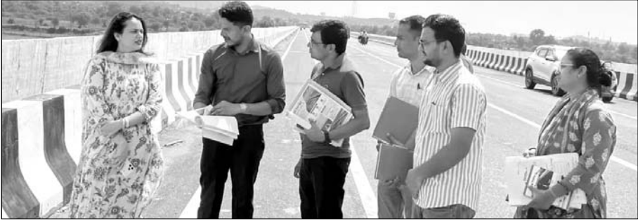
बनास नदी गहलोद पर सार्वजनिक निर्माण विभाग द्वारा निर्मित 3.3४0 किलोमीटर लम्बे पुल का जिला कलेक्टर टीना डाबी ने मंगलवार को निरीक्षण किया।
