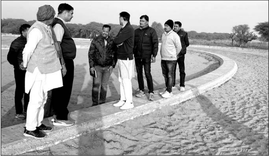
कस्बे में पिलानी रोड रेफरल अस्पताल के पास 12 करोड़ की लागत से बनने वाले निर्माणाधीन अंतरराष्ट्रीय खेल स्टेडियम का निरीक्षण करती जयपुर से आई कमेटी के अधिकारियों का।
