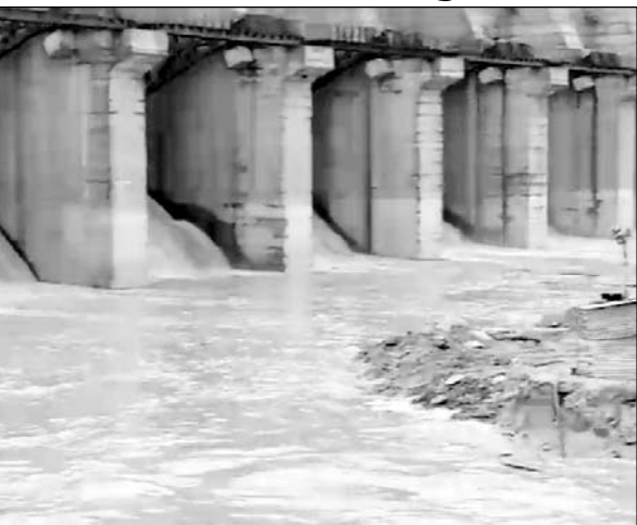
शनिवार सुबह बनास नदी में पानी की आवक बढ़ने से लबालब भरकर कॉपर डेम ओवरफ्लो हो गया।
