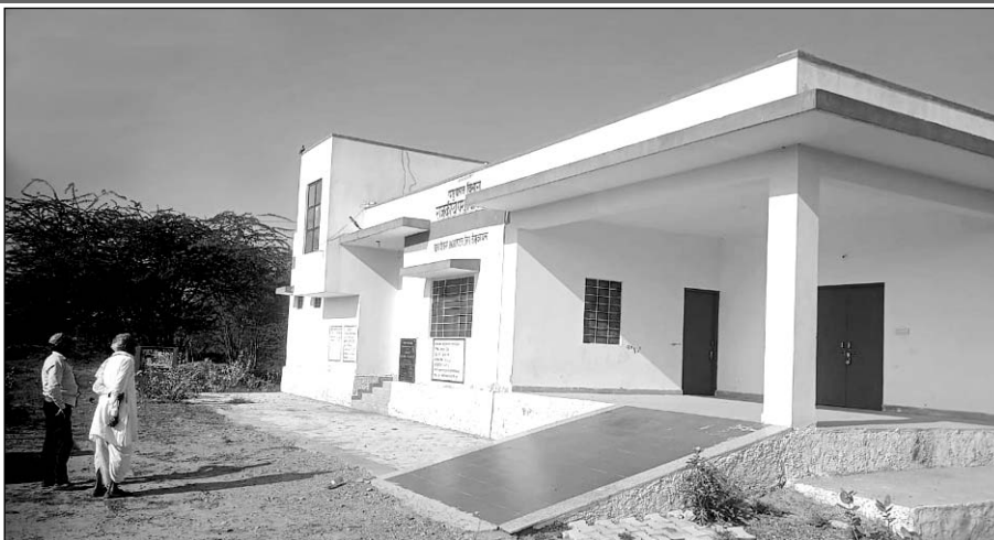
ग्राम पंचायत छाजा की नांगल में लाखों रुपये की लागत से बने पशु चिकित्सालय भवन में बीते तीन महीनों से चिकित्सक एवं पशुधन सहायक नहीं हैं।
