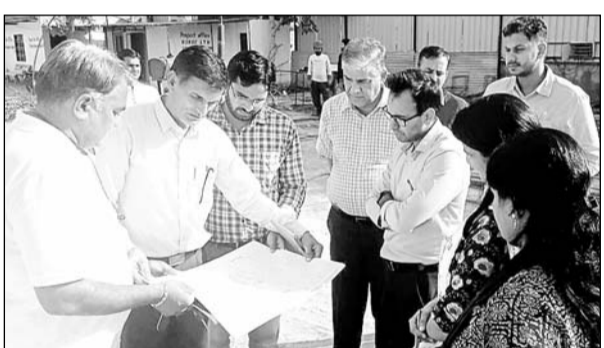
जिला कलेक्टर डॉ. खुशाल यादव ने जिला मुख्यालय पर बन रहे मेडिकल कॉलेज के भवन निर्माण कार्य का निरीक्षण किया।
