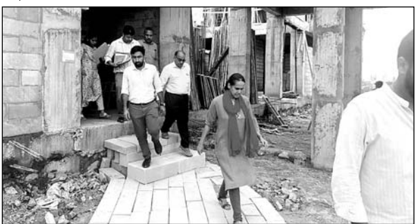
जेडीए आयुक्त आनन्दी ने निर्माणाधीन आईपीडी टावर का निरीक्षण किया।
