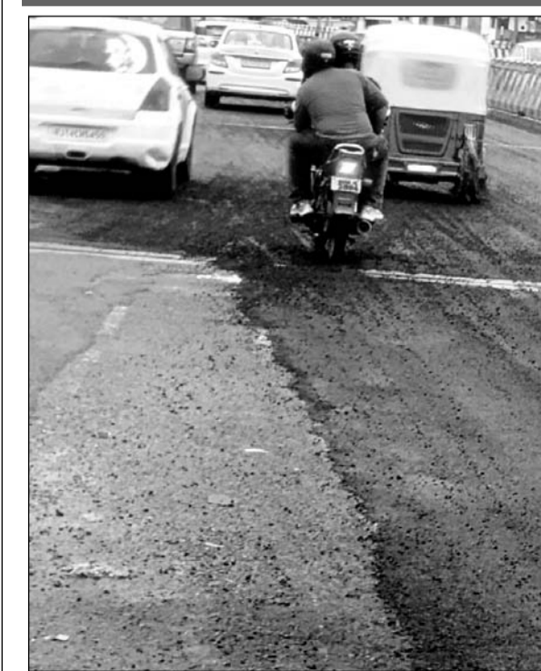
अजमेर एलिवेटेड रोड पर पेचवर्क उखड़ने के बाद सड़क पर बिखरी रोड़ी-कंक्रीट, जो हादसों को न्यौता दे रही है।
