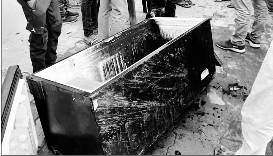
गांव रामपुरा में ट्रांसफार्मर में आई खराबी से घरों में बिजली उपकरण जल गए।
