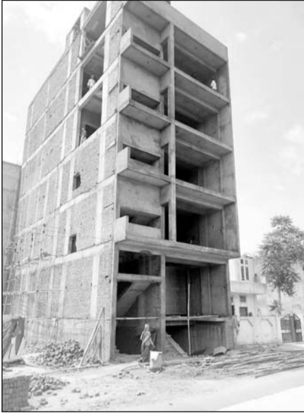
भूखंड संख्या 83/150 पर 6 मंजिला निर्माण
