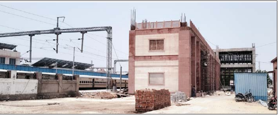
फुलेरा जंक्शन रेलवे स्टेशन पर पुनर्विकास निर्माणाधीन कार्य की धीमी गति होने से लोगों को परेशानी का सामना करना पड़ रहा है ।
