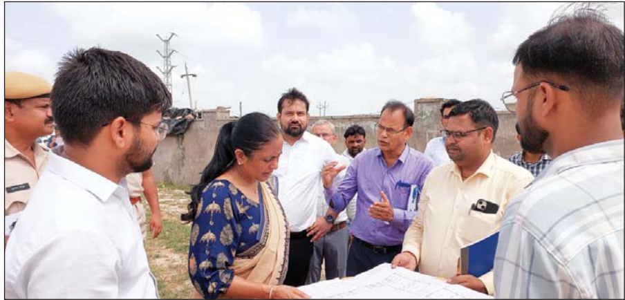
जिला कलेक्टर कल्पना अग्रवाल ने बुधवार को जिला मुख्यालय के ग्राम चराई स्थित निर्माणाधीन मेडिकल एवं नर्सिंग कॉलेज का निरीक्षण किया।
