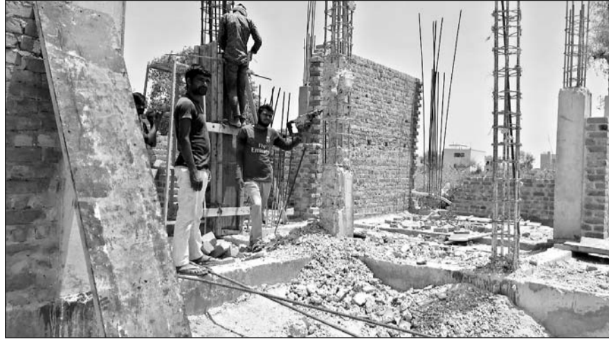
डीडवाना रेलवे स्टेशन पर विद्युतीकरण कार्मिक आवास निर्माण में जुटे मजदूर।
