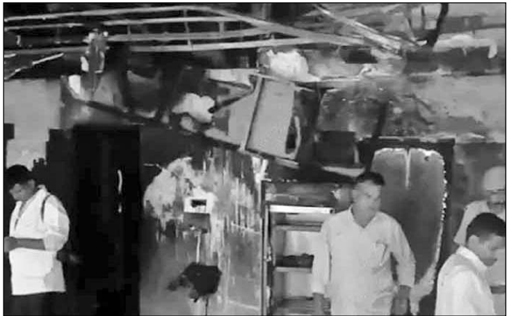
होटल में लगी आग की एफएसएल टीम और पुलिस ने जांच की।
