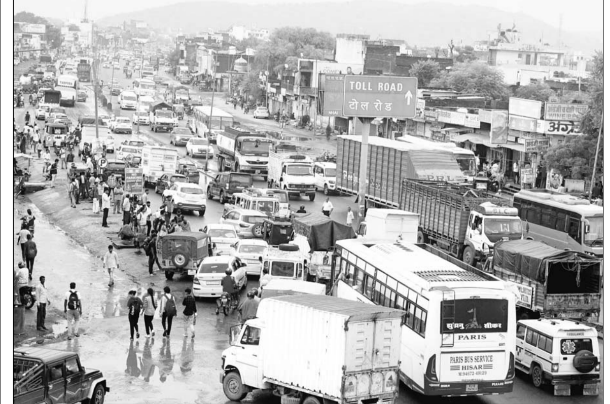
बारिश के कारण राजधानी जयपुर की अधिकांश सड़कें क्षतिग्रस्त हो गयी हैं। जयपुर-सीकर हाईवे की मुख्य सड़क में हरमाड़ा से लेकर 14 नंबर बाईपास तक जगह-जगह खड्डे हो गए हैं। इस कारण यहां से गुजरने वाले वाहन दिनभर हिचकोले खाते हुए धीरे-धीरे रेंगते हैं। सड़क इतनी बुरी तरह जर्जर है कि वाहन चालक मजबूरन सिंहाल लाइन में गाड़ियां चलाते हैं, ऐसे में यहां दिनभर भारी ट्रेफिक जाम की स्थिति बनी हुई है। हरमाड़ा थाने से लेकर वी.के.आई. चौराहे तक अधिकांश समय यातायात जाम की समस्या रहने से लोगों को परेशानियां झेलनी पड़ रही है।
