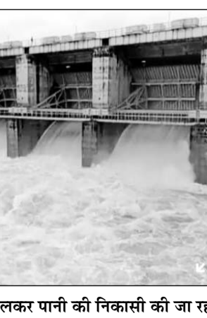
पांचना बांध के पांच गेट खोलकर पानी की निकासी की जा रही है।
